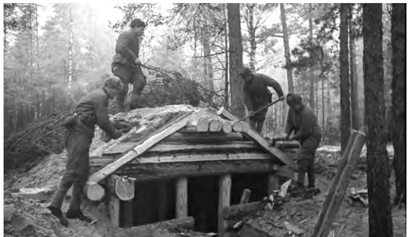
Abb. 16: Bau einer Semljanka durch Pioniere 1939
